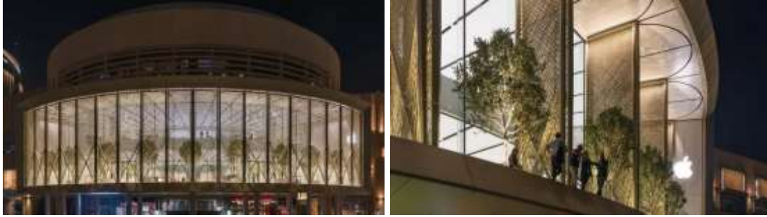
Resim 8. Apple Dubai Mall dış cephe ve iç mekan görselleri (Url-21; Url-22)
