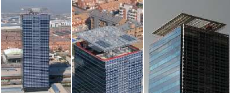
Şekil 7. Torre Garena Binası ve Fotovoltaik cephesi
