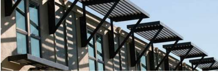
Şekil 3. Güneş kırıcı olarak kullanılan fotovoltaik sistemler (URL-1)
