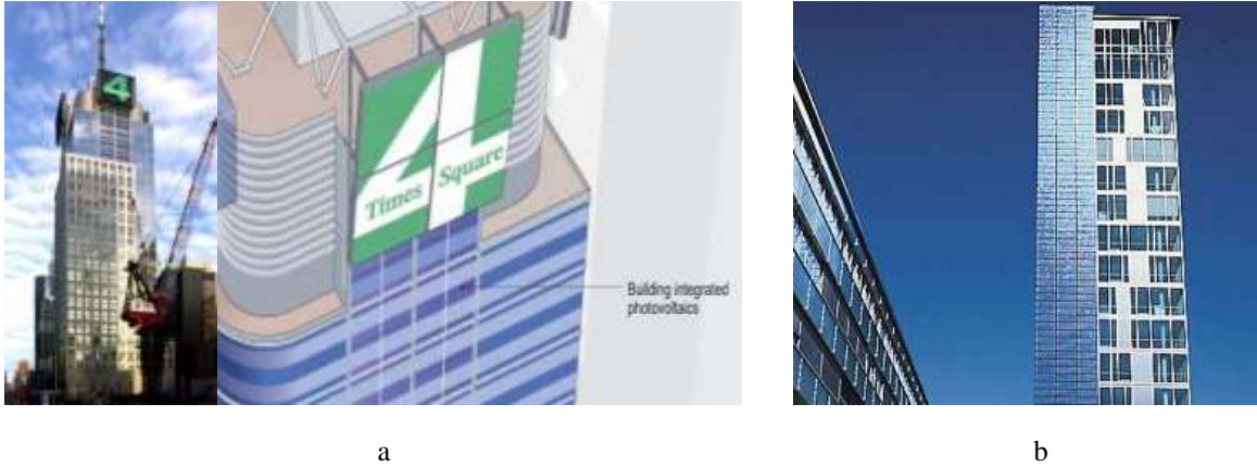
Şekil 5. (a)Times Square Binası ve cephede panel kullanımı, (b) Solar Tower Binası
