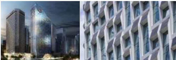
Şekil 12. Hanwha Headquarters Tower binası ve fotovoltaik cephe kurgusu
