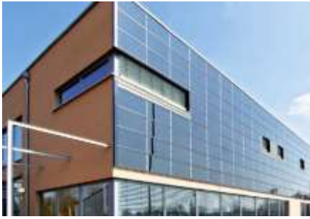
Şekil 4. Yağmur perdesi olarak kullanılan fotovoltaik sistemler (URL-2)
